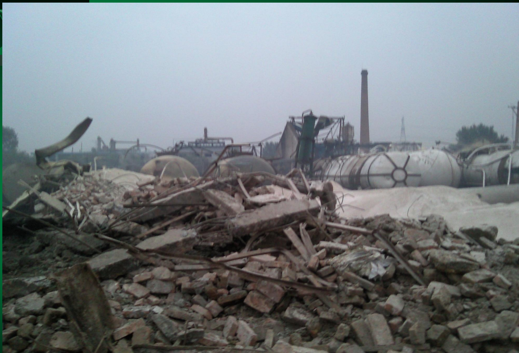
河南洛阳“7.15”爆炸事故现场
