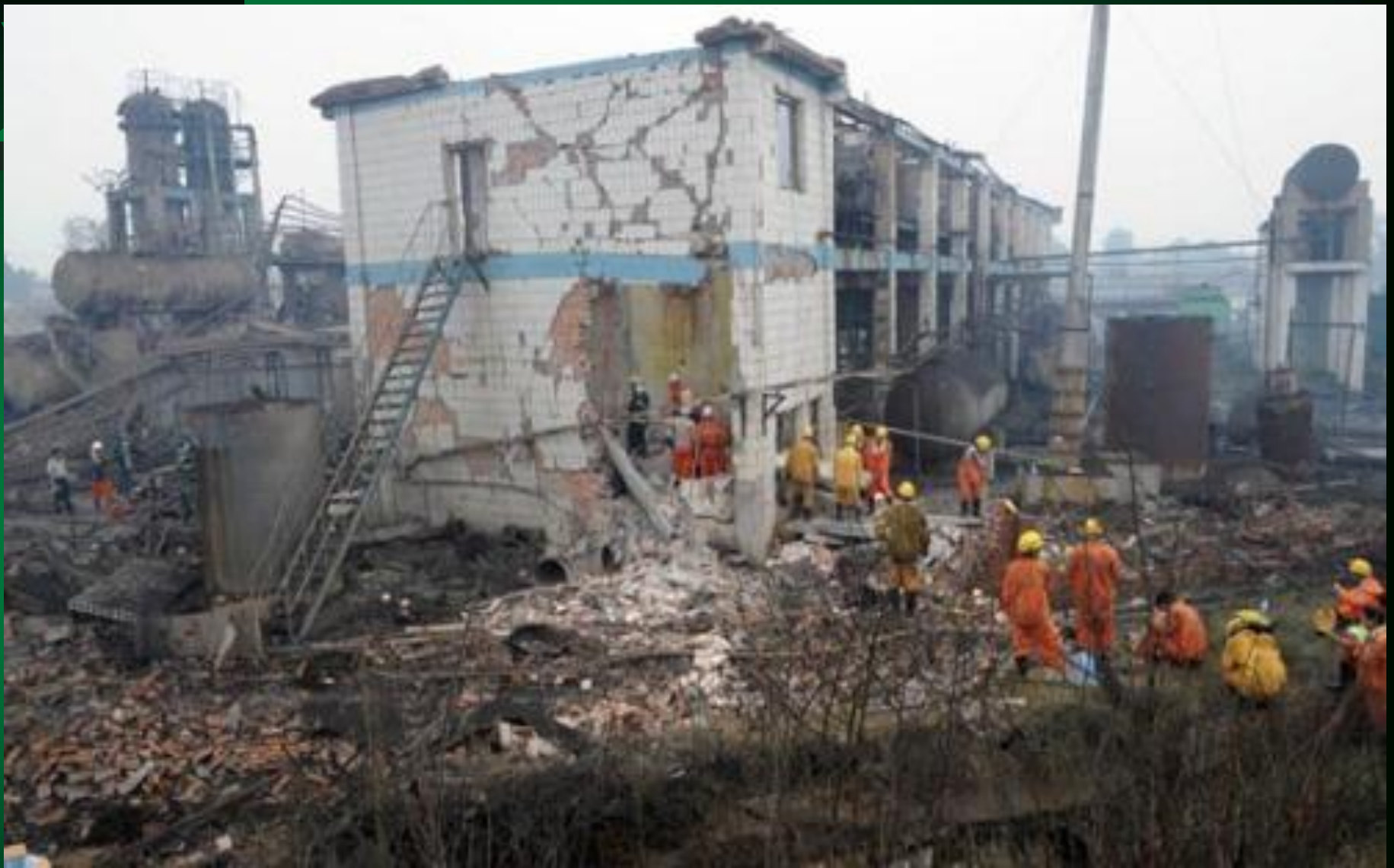
河南洛阳“7.15”爆炸事故现场
