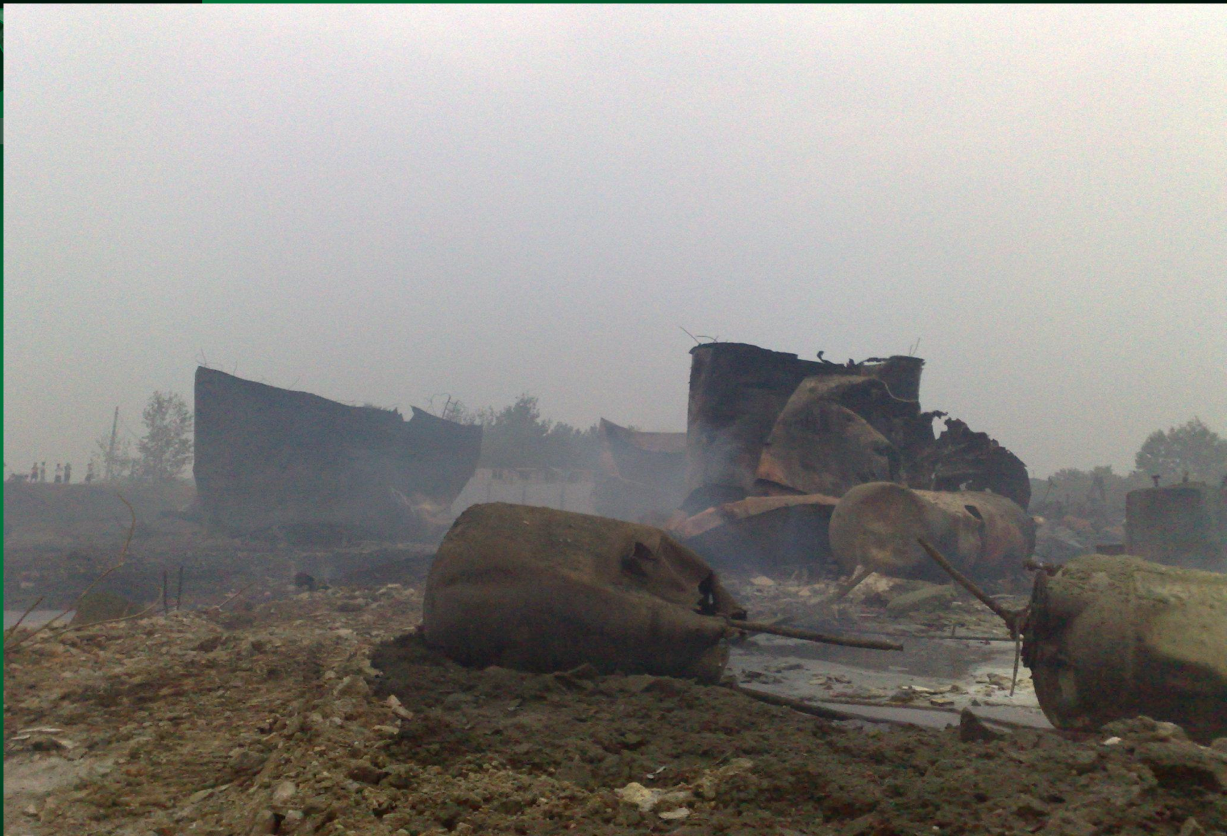
河南洛阳“7.15”爆炸事故现场
